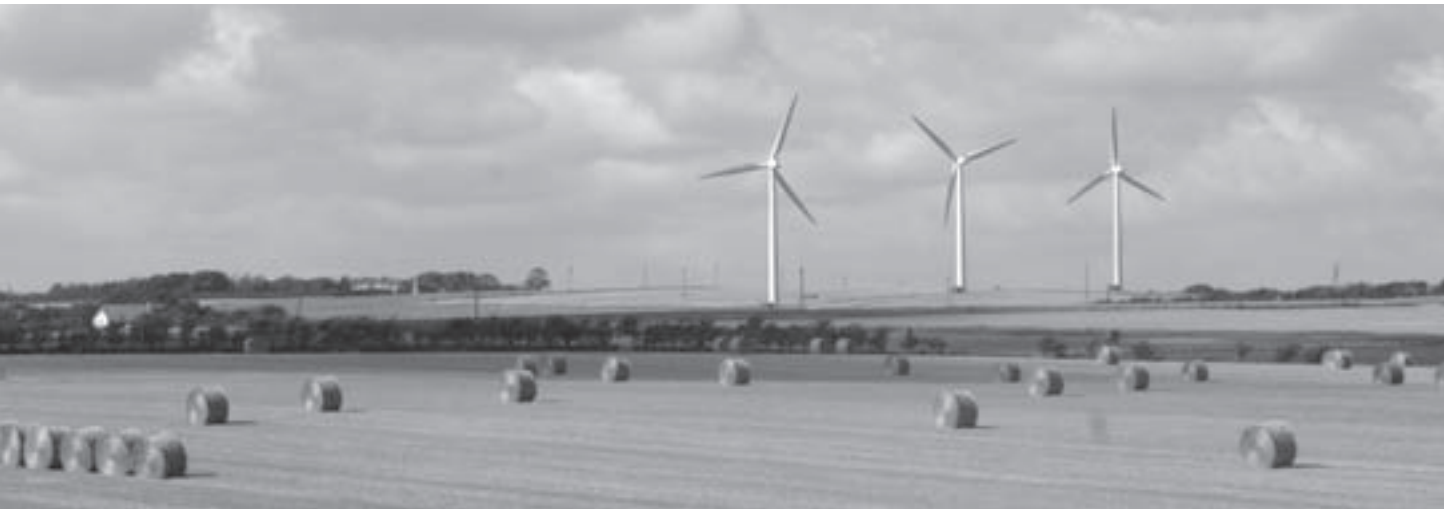
Næsby wind farm, Denmark
